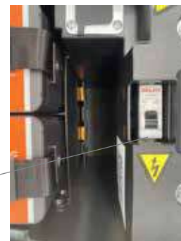
INTERRUPTORE GENERALE ON
