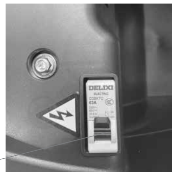
INTERRUTTORE GENERALE ON
